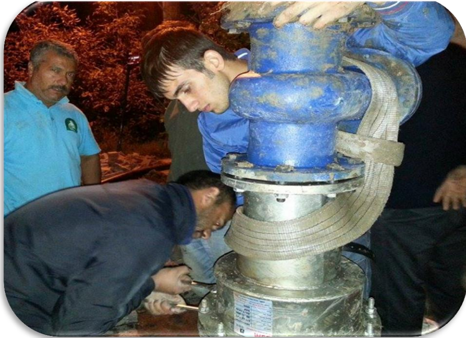
Fatih Mahallesi 44.Sokak Yeni Devlet Hastanesi Şebekeye Bağlantı işlemleri tamamlandı.
