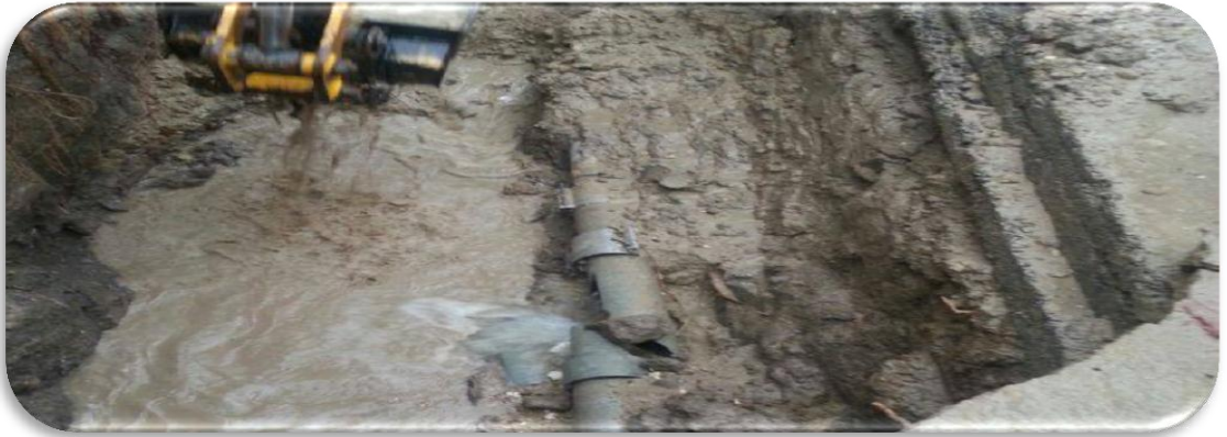
1.Murat Mahallesi Ali Rıza Atatürk Caddesi Q100 AÇB Boru Tamirâtı Tamamlandı.
