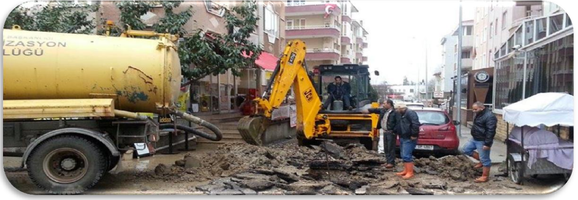
1.Murat Mahallesi 1.Sokak. Q100 AÇB Boru Tamirati Tamamlandı.
