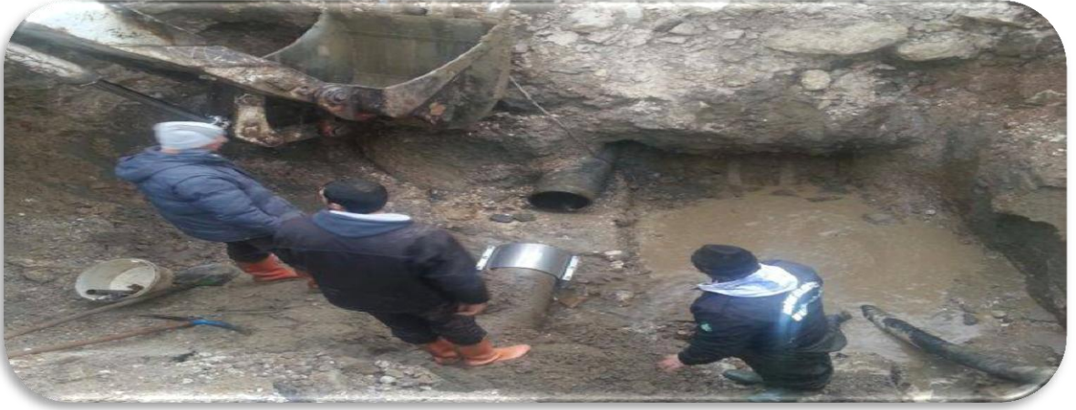
Babademirtaş Mahallesi TekkekâpıCaddesi Q300 AÇB Boru Tamirâtı tamamlandı.
