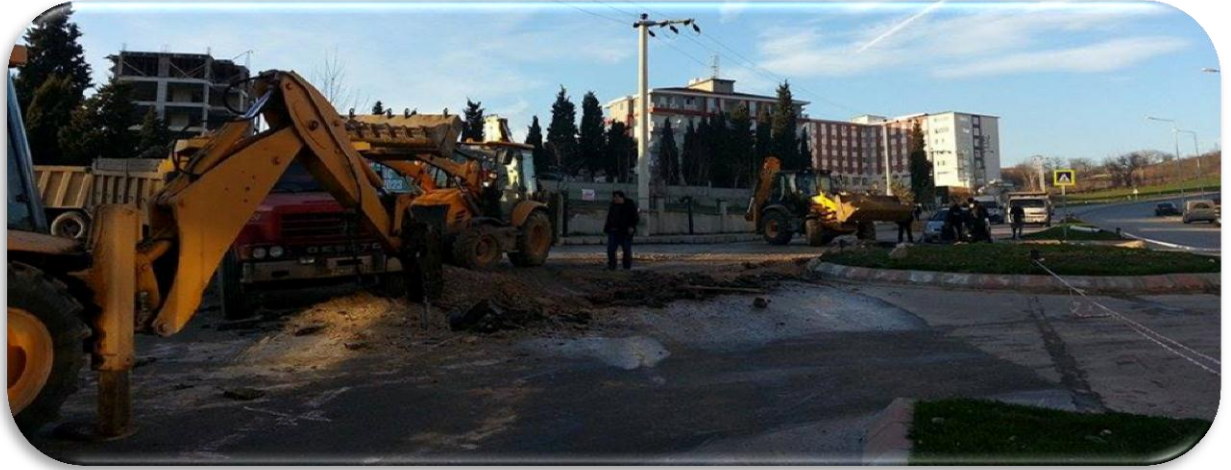
Resim 02: Bahii Mezarlığı Bölgesi Yeraltı Suları Toplama Kanalı İnşaatı
