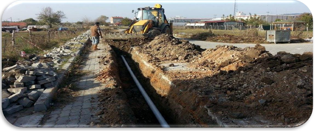
İstasyon Mah. Yeni Cad. 102 mt 110 PVC boru döşemesi yapıldı
