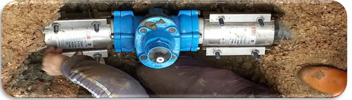
1. Murat Mahallesi Jan. Üst. Ahmet ALTIN Caddesi Kosova Yerleşkesi önü vana değişimi
