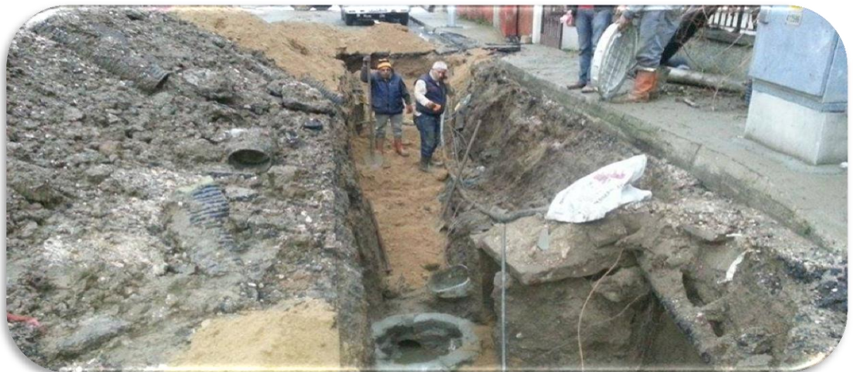
Resim 04: 1. Murat Mh. 128. Çıkmaz Sokak Kanalizasyon Kanalı Tamir ve Yenileme İnşaatı
