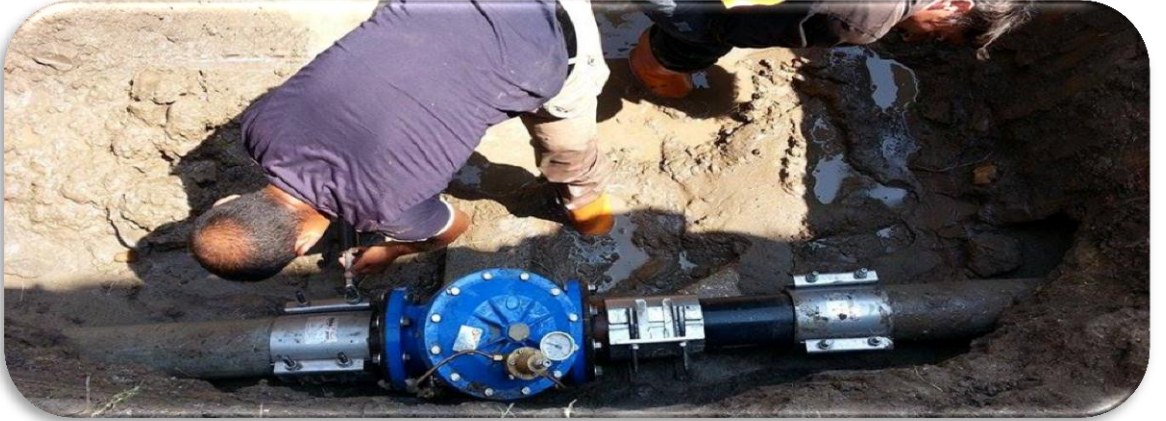
MargiOutlet-Karayolu Lojmanları basınç düşürücü vana montajı
