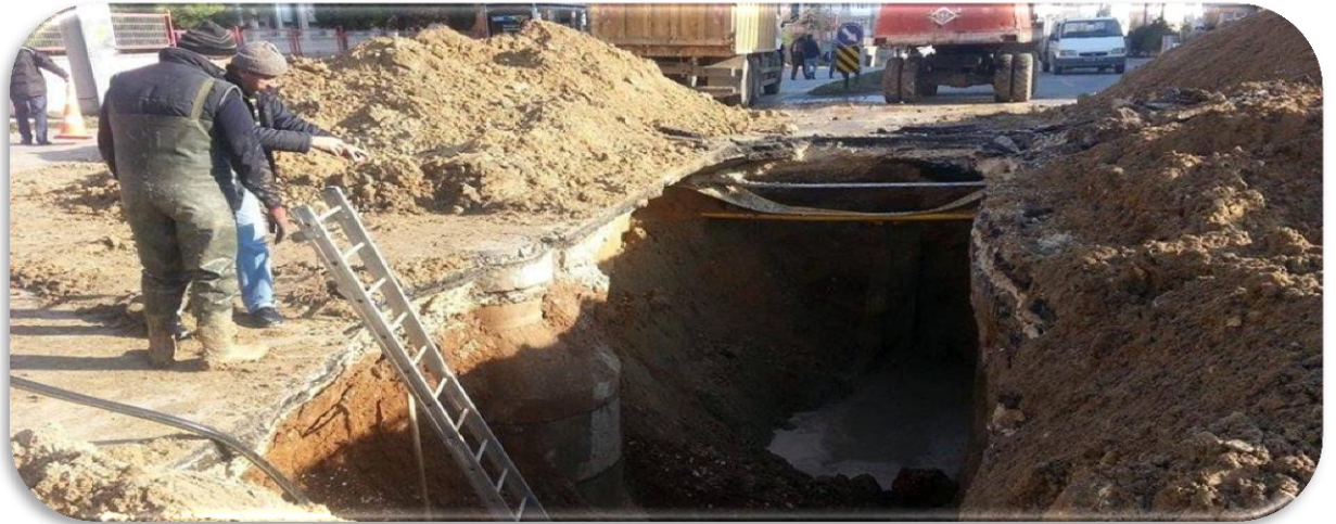
Resim 03: Fatih Mh. İbrahim Ay Cd. Kanalizasyon Kollektör Kanalı Tamir ve Yenileme İnşaatı
