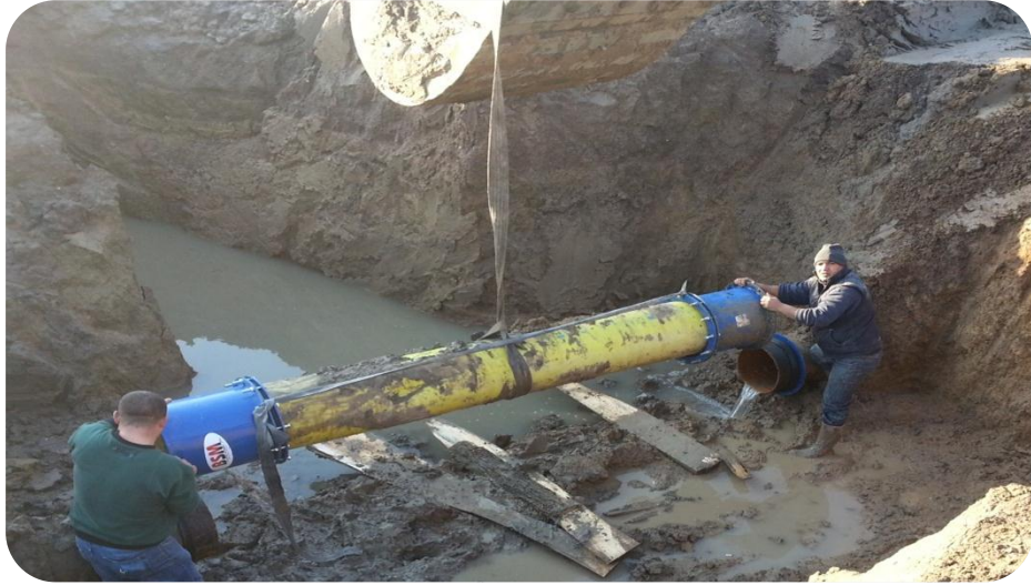
Ø400 Pik - Ø400 Çelik Boru Birleřtirme Adaptörü ile Ana Boru Tamirâtı
