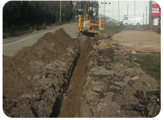
Yeni İtfaiye Binası Su Bağlantısı
