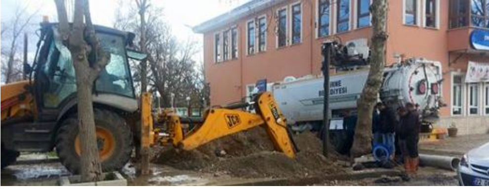
Karaağaç Yolu üzerinde bulunan 250 Pik boru tamiri yapıldı.
