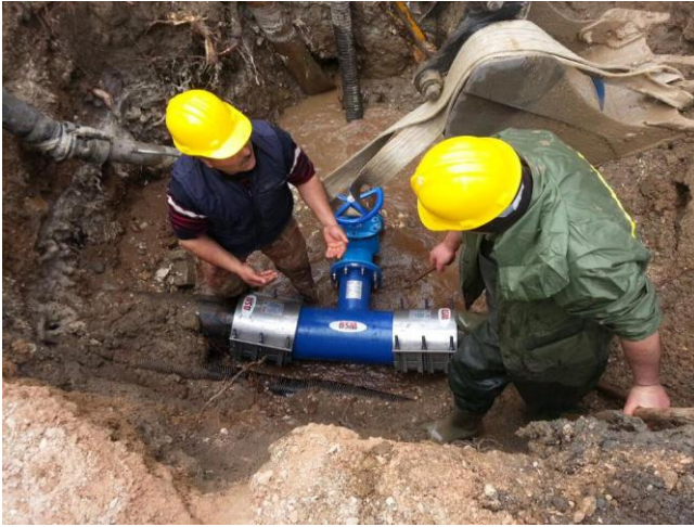
Kocasinan Mahallesi Muammer Aksoy Caddesi'nde bulunan 100 ACB boru tamiri yapıldı.
