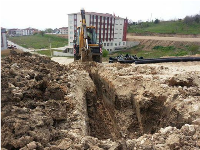
İmara açılan yeni yerleşim bölgesinde su ve kanalizasyon şebekesi döşeme çalışması
