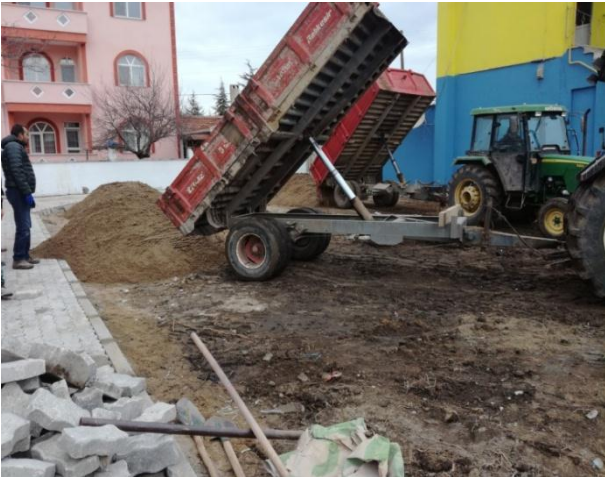
Yeniimaret park yapımı çalışması
