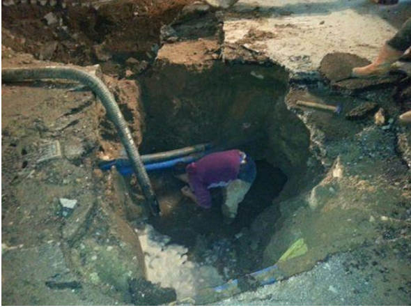
Abdurrahman Mahallesi Kanal Sokak'ta bulunan 350 AÇB boru tamiri yapıldı.
