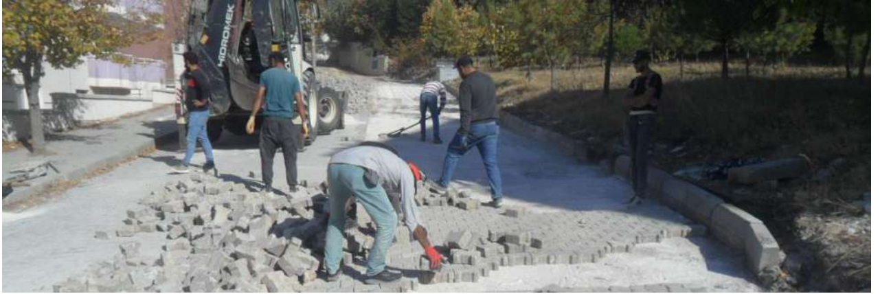
Müdürlüğümüzce Yapılan Parke Taş Tamir Çalışmaları
