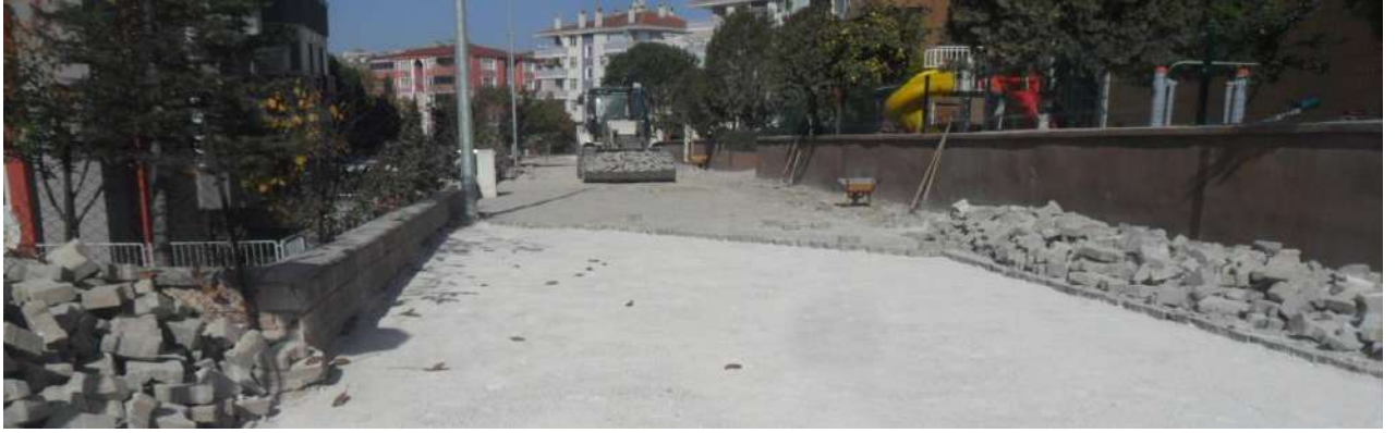
Müdürlüğümüzce Yapılan Parke Taş Tamir Çalışmaları
