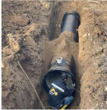
800 mm Düktil Boru İçmesuyu Şebeke İmalatı
