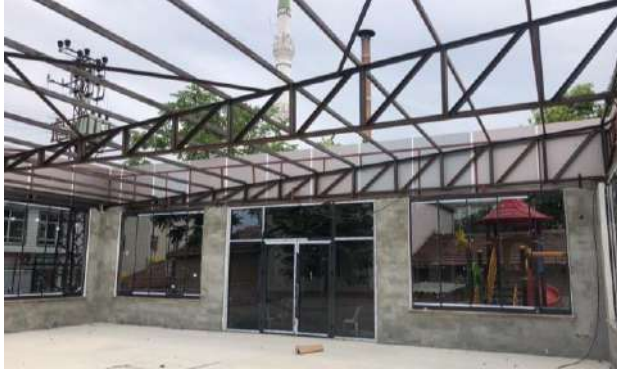
Meriç Belediyesine Bekleme Salonu Yapılması
