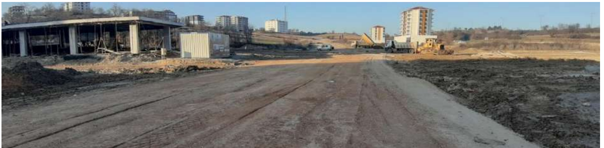
Müdürlüğümüzce Yapılan Hafriyat ve Yol Açma Çalışmaları
