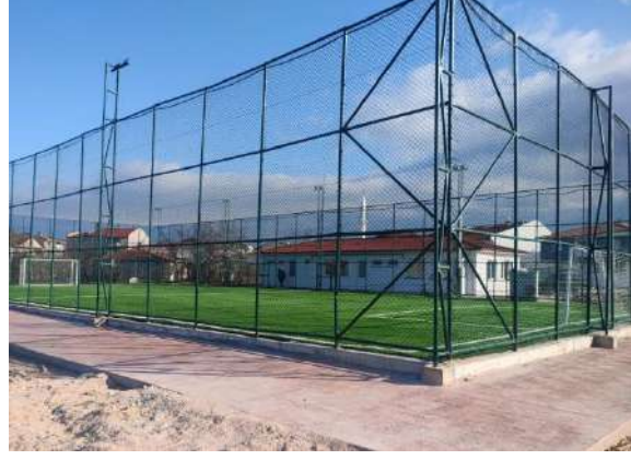
İstasyon Mh. Halı Saha Yapılması
