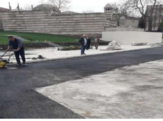
Selimiye Camii Çevresi Alan Düzenleme Çalışmaları
