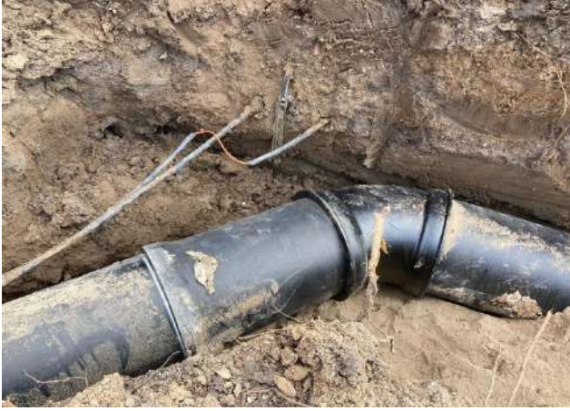
800 mm Düktil Boru İçmesuyu Şebeke İmalatı
