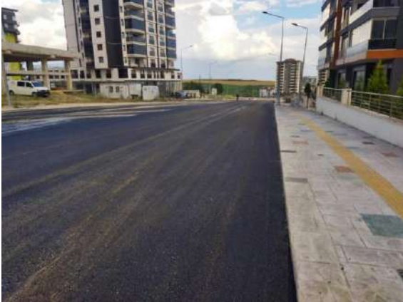
Çeşitli Asfaltlama Çalışmaları
